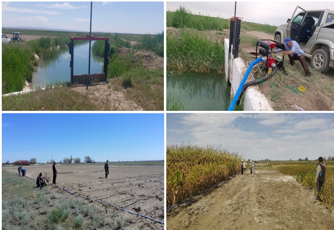
Рисунок 3 – Укладка капельной ленты и полив культур на деградированных почвах Акдалинского массива орошения на полях ТОО «Агрофирма Бірлік» Балхашского района
