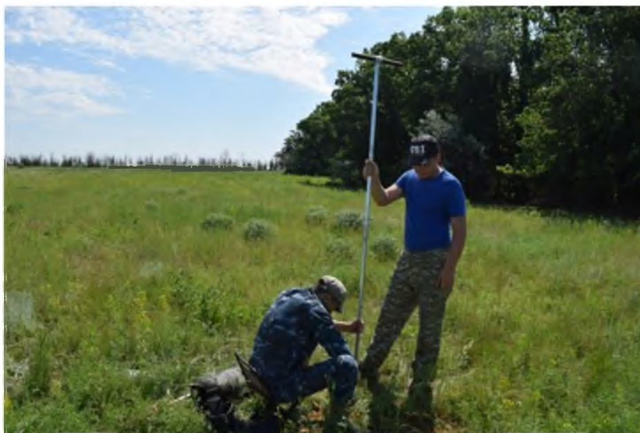
Рисунок 1 – Закладка мониторинговых скважин для наблюдения за УГВ
