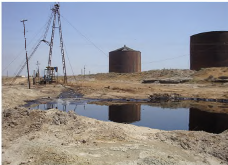
Рисунок 2 – Состояние нефтезагрязненных территорий вокруг буровой скважины, Бинагадинефть
